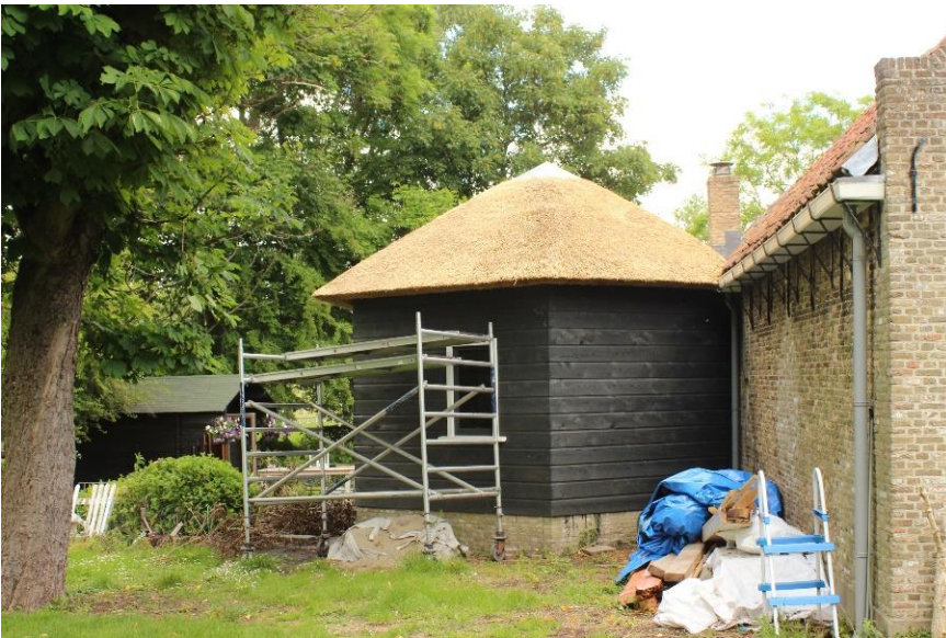
2022-05 karmolenhuis nieuw gebouwd
