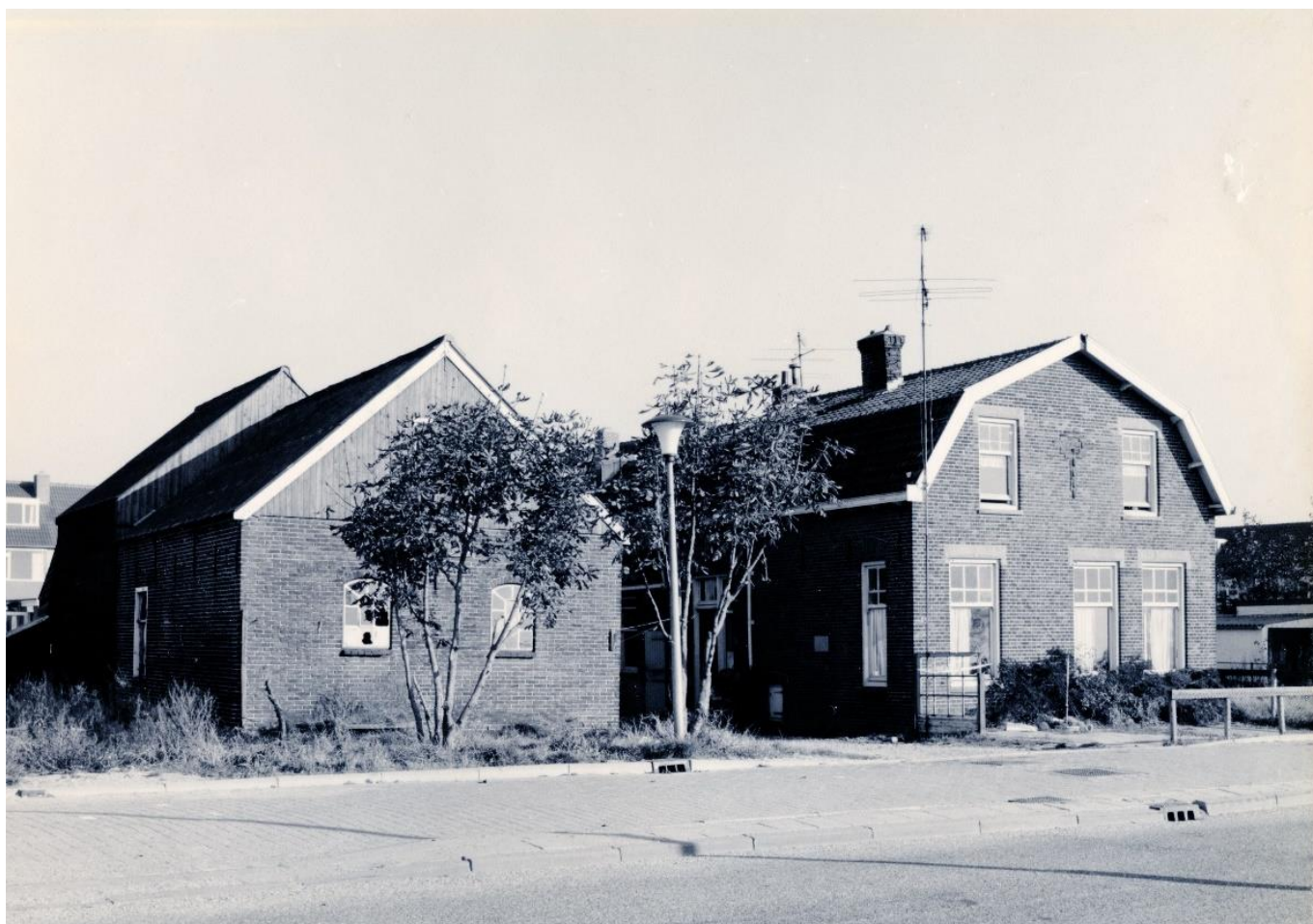
Noordweg 66 (oud nummer), in 1923 gebouwd op perceel C27 levensboom op voorgevel
