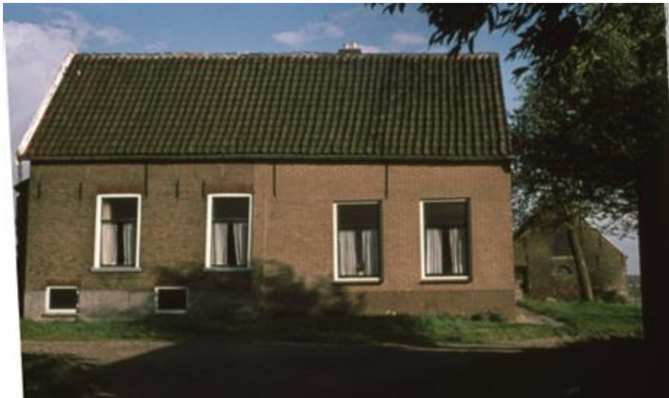
voorgevel voor herbouw
