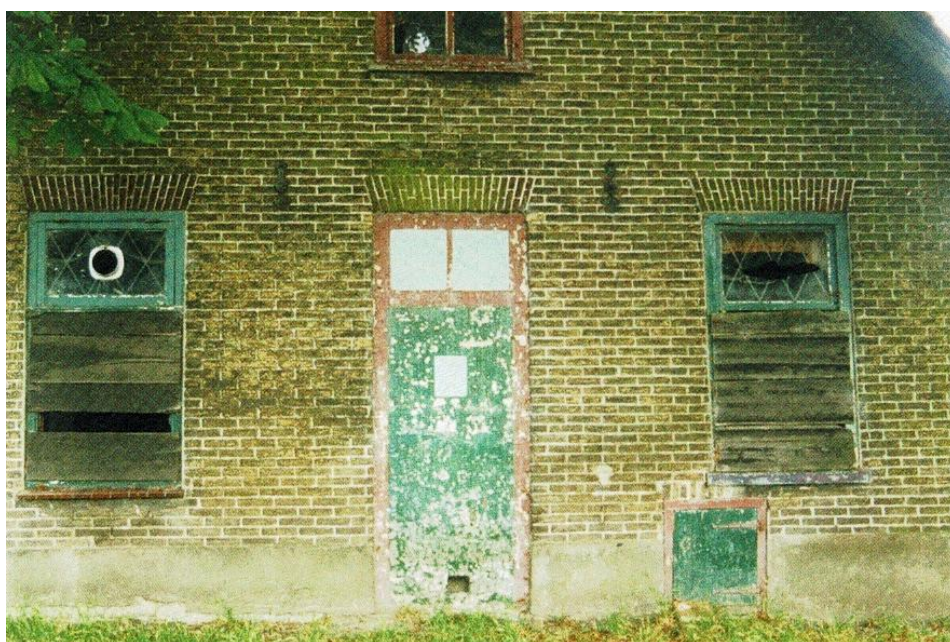
De nepvoordeur in de voorgevel van de boerderij van Noordam. Rechts van de voordeur het nepluik naar de pet in de melkkelder van de boerderij.
