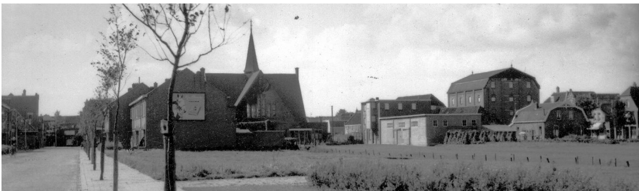
Emmapark gesloopte huizen "Dame Blanche" reclamebord op kopgevel
