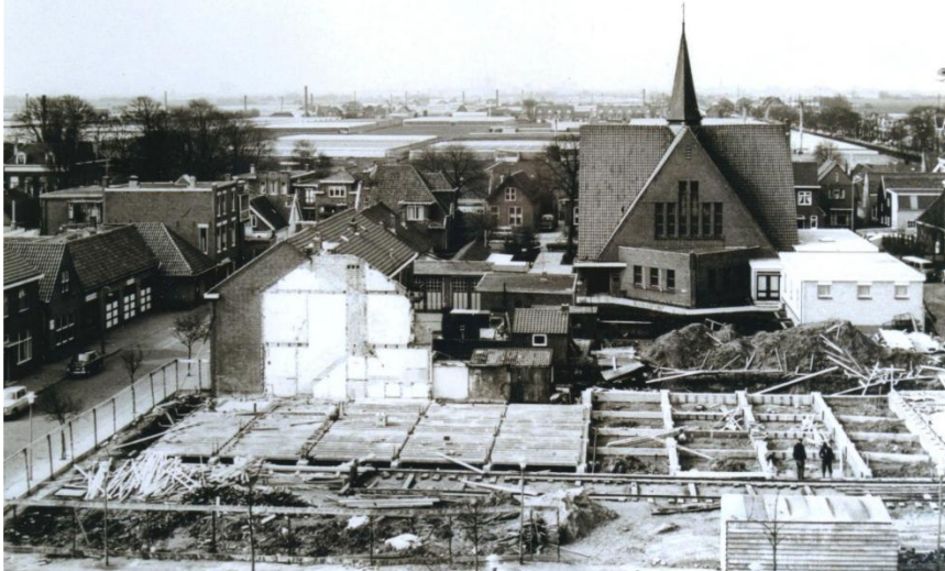
Emmapark raadhuisplein start bouw winkelstrip rij 4 huizen ("Van Leeuwen") gesloopt rij 'witte huisjes' van Gereformeerde kerk en andere rij huizen (evenals kerkgebouw) nog niet gesloopt
