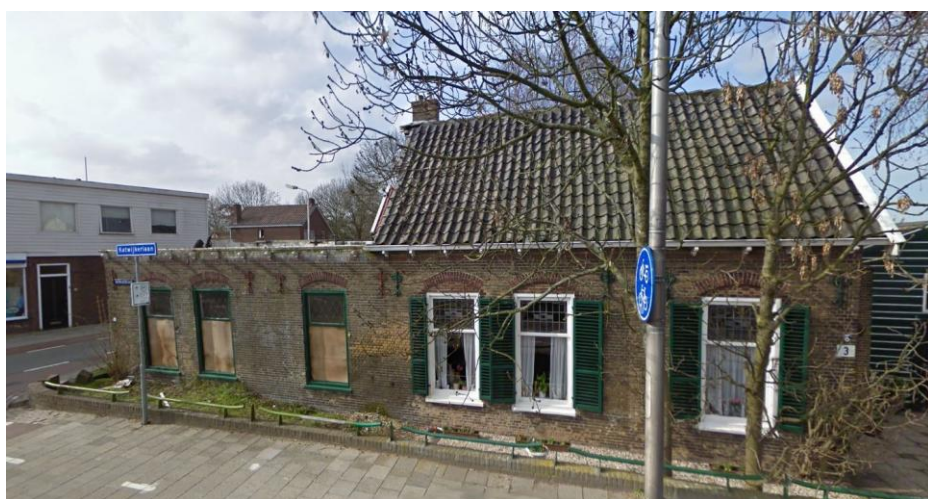
2008, restanten Katwijkerlaan 1 na brand, vóór sloop.
