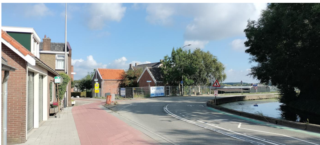
2022-08 Katwijkerlaan 3, aanvang sloop, asbestsanering dak schuurtje
